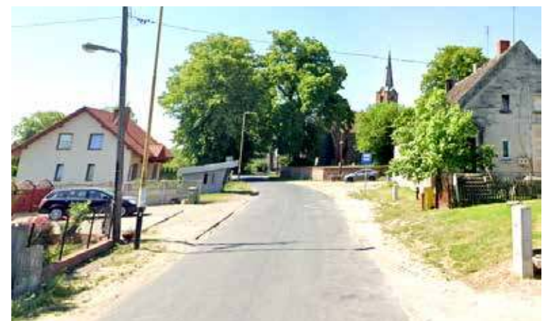
Przebudowa drogi w Kulicach będzie mogła ruszyć, ale dopiero po zabezpieczeniu środków na ten cel
