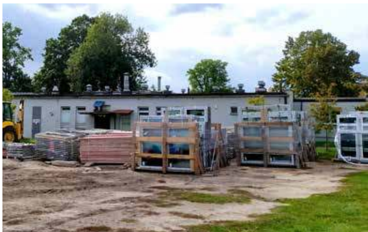
Już na początku tygodnia teren przed szpitalem zamienił się w plac budowy
