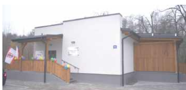
To już kolejny budynek w gminie. Ze świetlicy skorzystają mieszkańcy Zarzeczca, ale również Zarzeczca, Janowa, Kochanowa oraz Sosnowa
