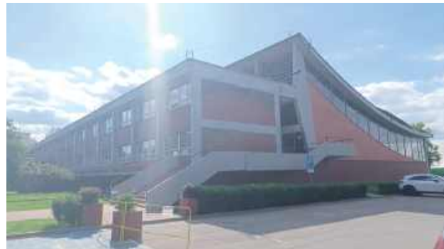
Stara hala zostanie przebudowana i zmodernizowana. Po remoncie basen kryty będzie większy, a w środku będzie m.in. ścianka wspinaczkowa
