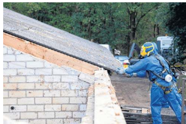
Dotacja finansowa z miasta pozwala na demontaż, transport i utylizację wyrobów azbestowych
