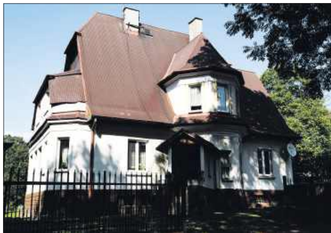
■ Eklektyczny dworek z 1925 roku, zwany willą, w którym mieszkali zarządcy folwarku, a następnie kierownicy PGR-u
