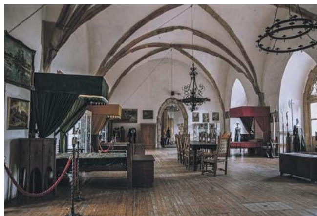
Sala Książęca – jej głównym elementem poza prezentacją wyposażenia, jest trójpłaszczyznowe sklepienie krzyżowe o rozpiętości ponad 9 m oraz neogotycki kominek
