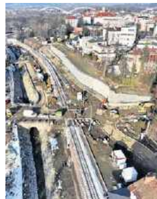
Prace w rejonie przejazdu kolejowo-drogowego
