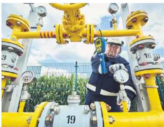
Budowa gazociągu - zdjęcia ilustracyjne, archiwum GAZ-SYSTEM
