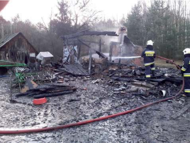
Na miejscu pożaru strażacy pracowali ponad trzy godziny
