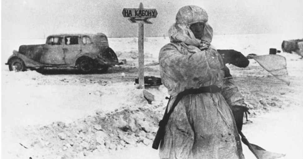
Kontroler ruchu na tzw. Drodze Życia nad jeziorem Ładoga.
