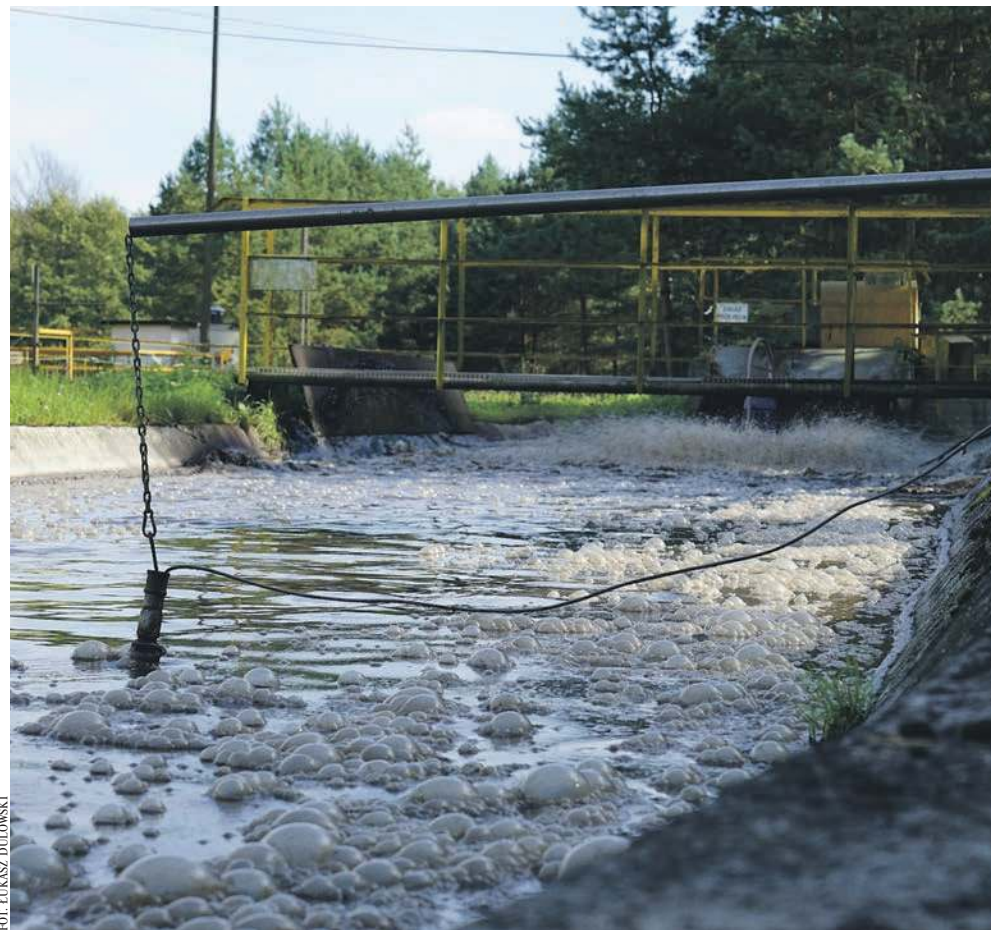
Stara oczyszczalnia ścieków znajduje się na terenie spółki Alventa (dawnej Zakłady Chemiczne Alwernia)
