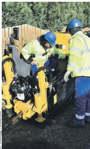
Ekipa Wodociągów Chrzanowskich w trakcie pracy przy kanalizacji
