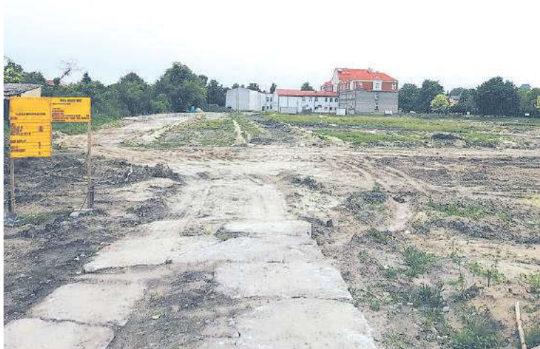
Przerwa na budowie stadionu trwa już trzeci miesiąc
