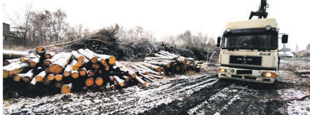
Porządkowanie terenu pod budowę bloków wielorodzinnych na osiedlu Kąty w Chrzanowie
