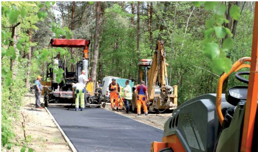
W pierwszej połowie maja wylana została nawierzchnia bitumiczna na ścieżce pieszo-rowerowej
