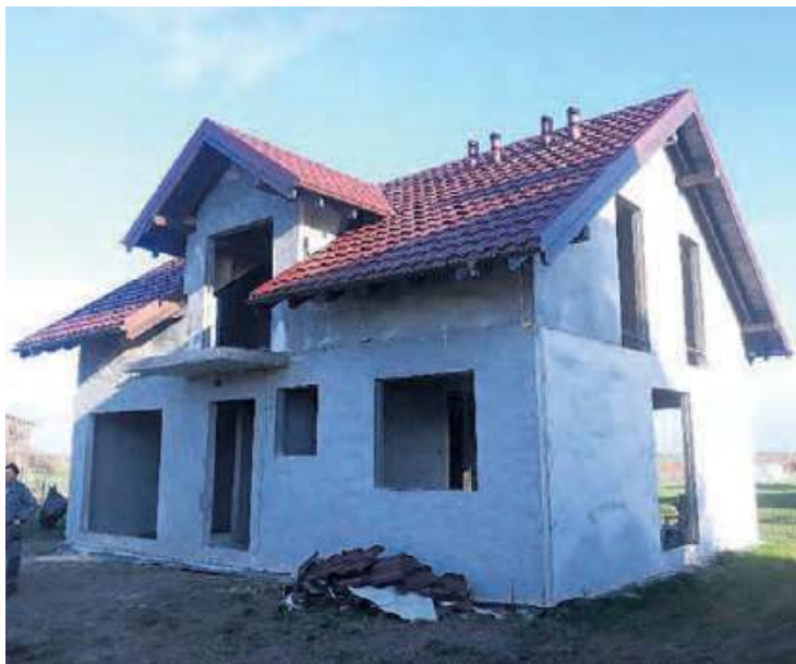
Dach sztyty na miarę.
