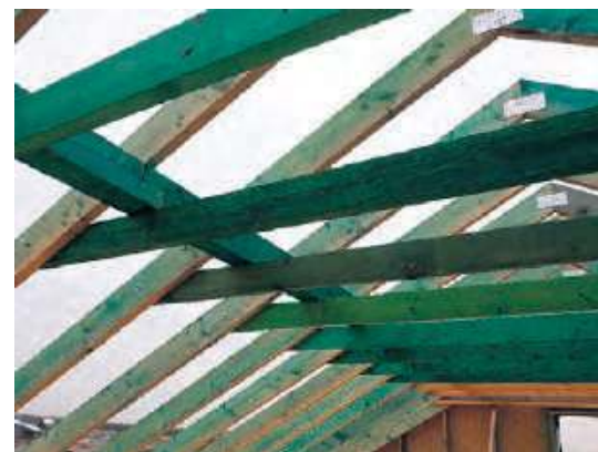
Więźba dachowa jest ważną częścią całej konstrukcji.
