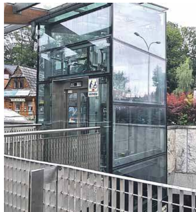
Winda w przejściu podziemnym nie działa już trzeci miesiąc.
