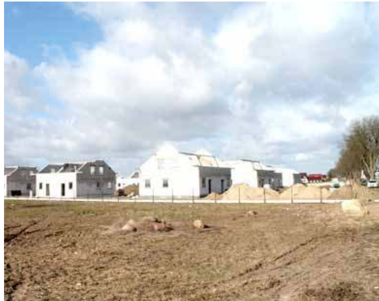
Taka zabudowa w ostatnich latach jest najchętniej lokalizowana na terenie gmin Kobylanka i Stargard
