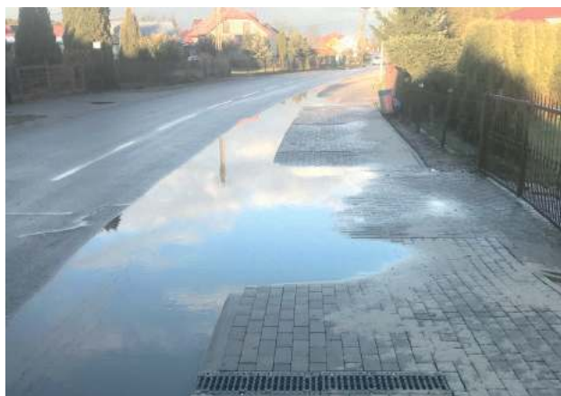
Przez wiele dni po opadach na ul. Słonecznej zalega woda, którą samochody rozchlapują na chodniki i ogrodzenia. Odpływy umieszczono ponad kałużami...
