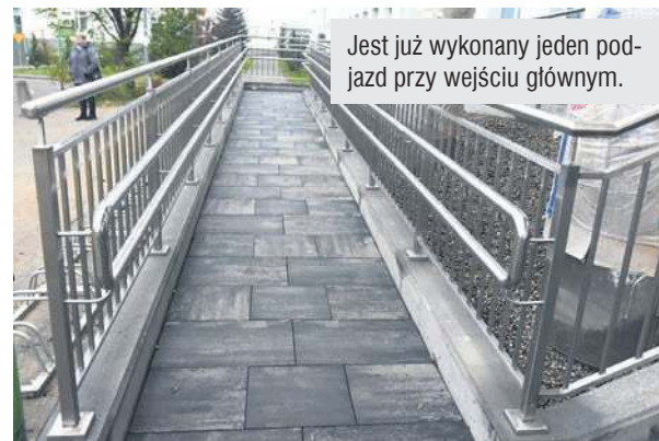
Obecnie prace w dużej mierze skupione są przy wejściu głównym szpitala.
