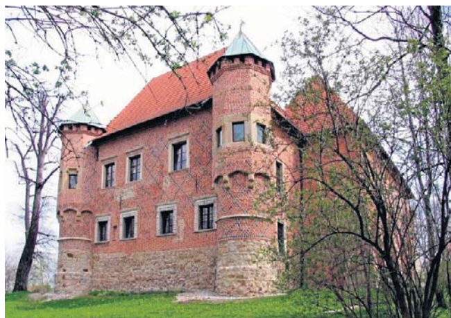
Zamek w Dębnie. Remont przyczyni się do tego, że obiekt będzie dostępny dla turystów przez cały rok
