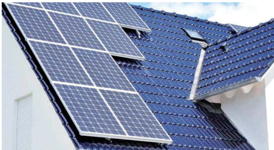
W tym roku trwa montaż Odnawialnych Źródeł Energii – projektu o wartości blisko 5 mln. zł.
