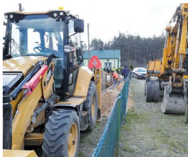
Budowa sieci kanalizacji.
