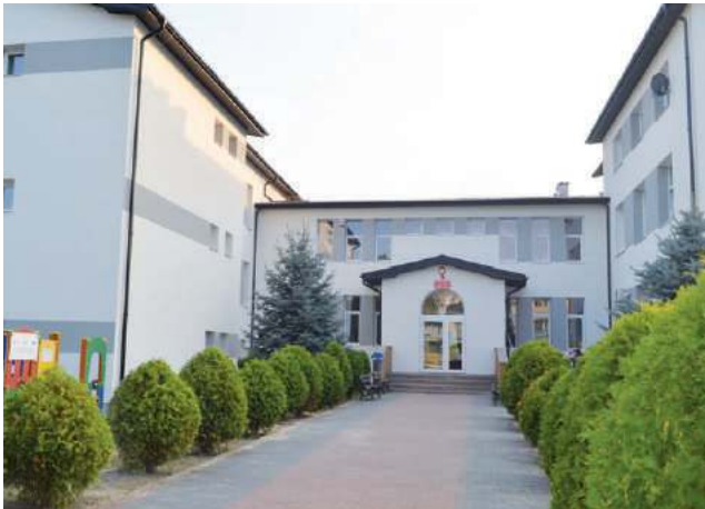
Termomodernizacją objęto wszystkie szkoły z terenu Gminy
