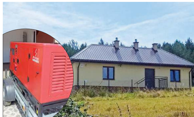
Stacja uzdatniania wody.
