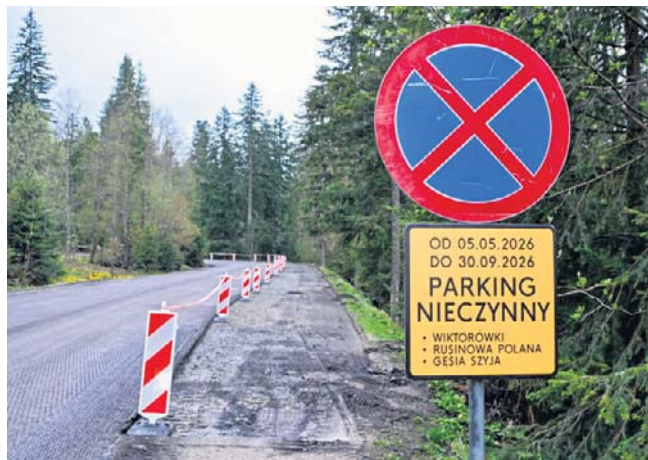
Zamknięty parking na remontowanej drodze Oswalda Balzera
