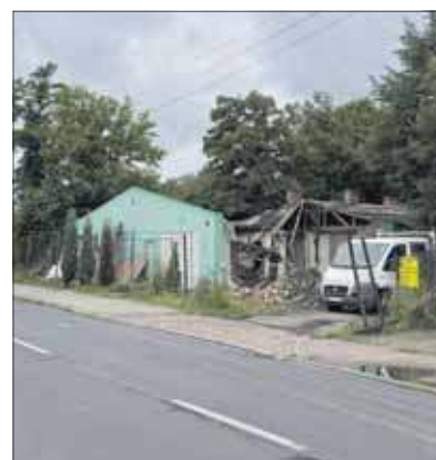
Rozbiórka dawnej izby wytrzeźwień
