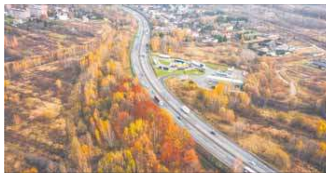
Miejsce powstania węzła Klimontów na trasie S1 (fot. GDDKiA)
