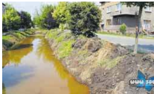
Kozi Bród, rok 2026 – muł wydobyty z rzeki w trakcie prac
