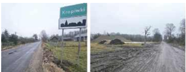
Prace już trwają, droga zostanie poszerzona
