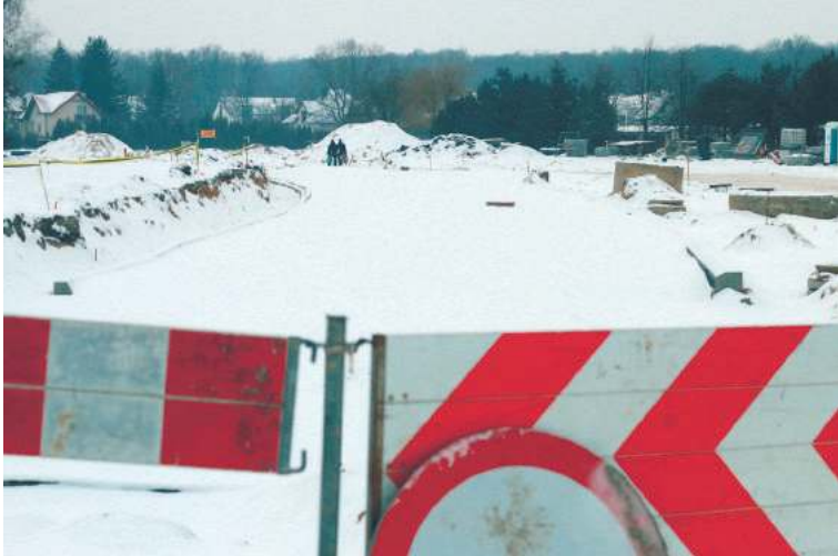
Budowa ulicy Kusocińskiego potrwa do 2020 roku
