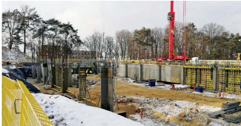
Przy Fabrycznej trwa już budowa konstrukcji hali basenowej
