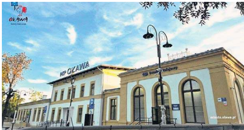
Remont zabytkowego budynku dobiega końca
