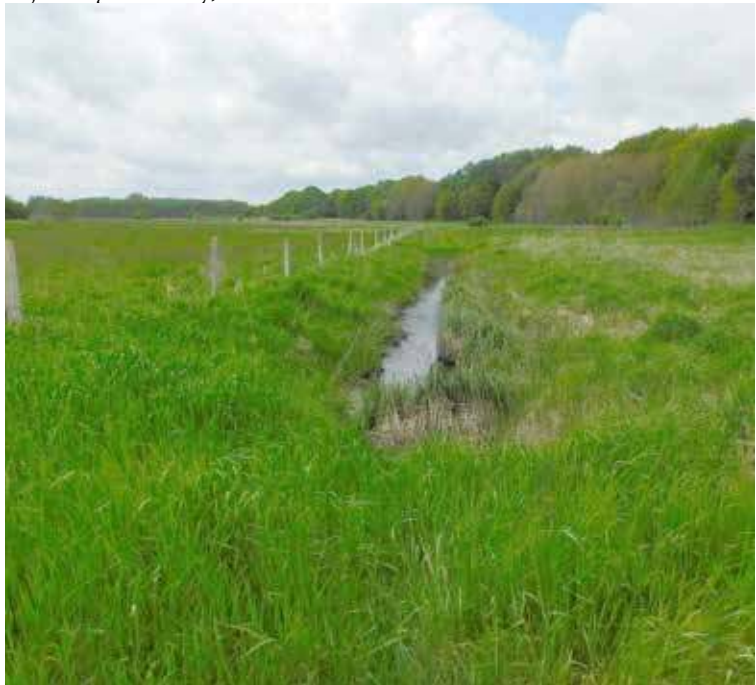
Woda zamiast płynąć to stoi, ponieważ przepust zasypyany i zarośnięty. Dolina za byłą cegielnią na Radosławiu
