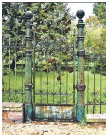
W ramach projektu przeprowadzona zostanie renowacja bramy ogrodzeniowej skweru przy ul. Ogrodowej
