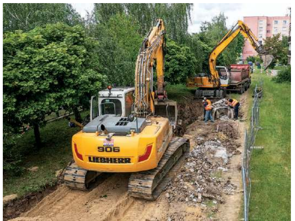
Powstaną nowe oświetlone drogi, ścieżki rowerowe i chodniki
