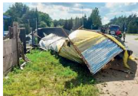
Dach przy drodze Lubowidz-Galumin
