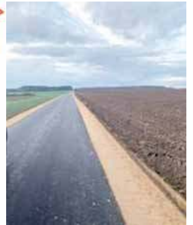
Fragment zmodernizowanej drogi Bogurzynek – Mdzewo
