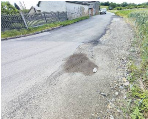
A tak wygląda po wymianie asfaltu i utwardzeniu pobocza
