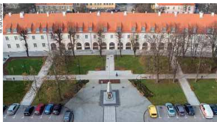
Krzywa Hala na osiedlu Bloki odnowiona dzięki unijnym środkom
