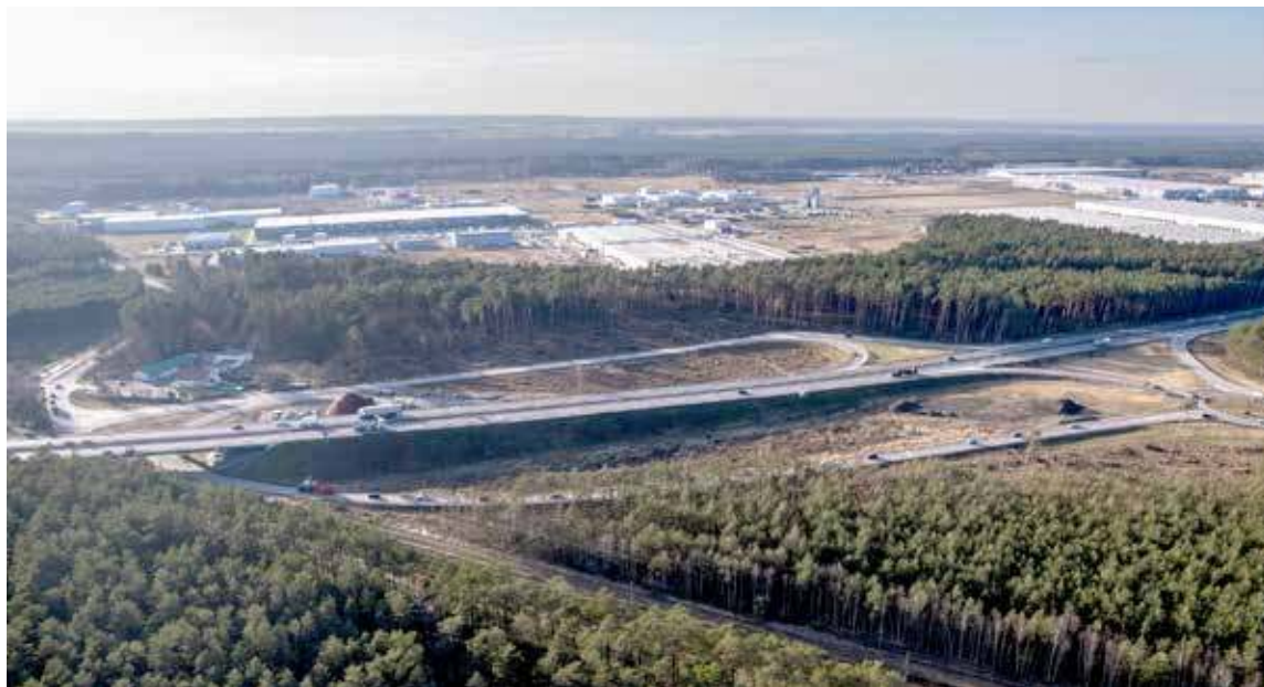
Zdjęcie z powietrza węzła Goleniów Południe
