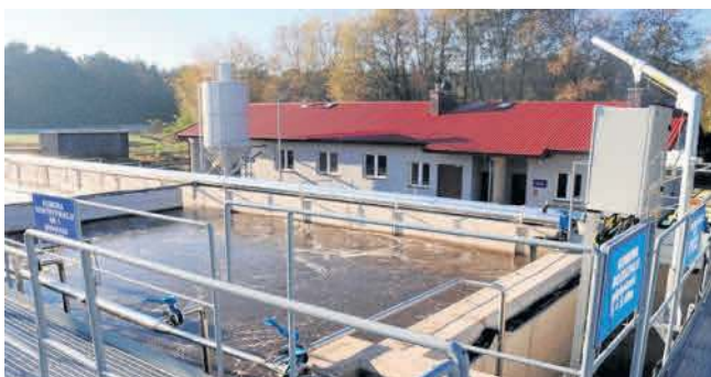
Oficjalne otwarcie oczyszczalni ścieków, której budowa zaczęła się w 2017 roku nastąpiło w zeszłym miesiącu
