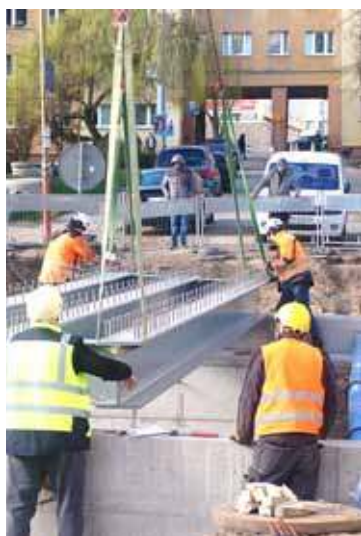
Nad Kanałem Młyńskim została umiejscowiona konstrukcja mostu
