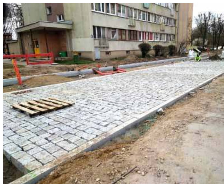
Na ul. Szewskiej została już zrobiona kanalizacja deszczowa i sieć oświetleniowa.
