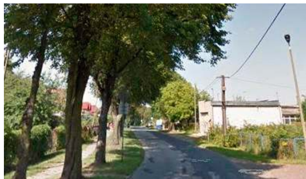
W pierwszym etapie przebudowy ulicy Dworcowej wyremontowany zostanie odcinek od ul. Struga do ul. Leśnej
