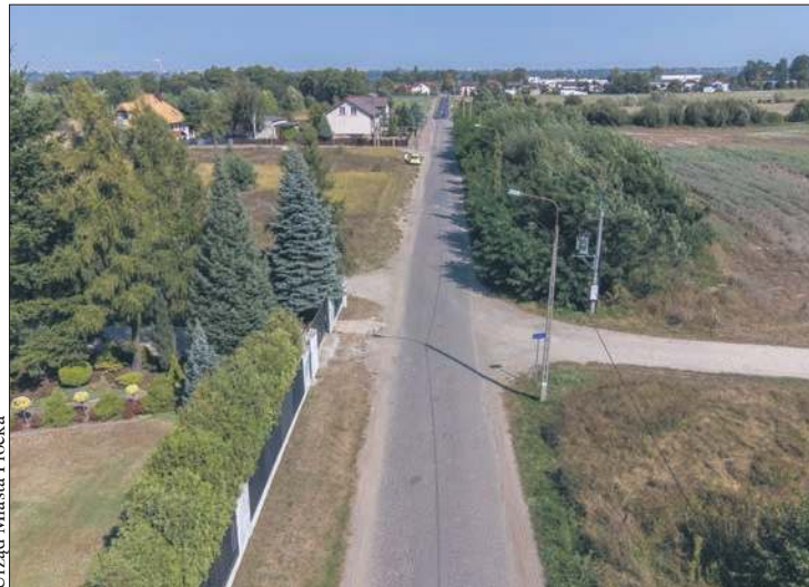
Rozpoczyna się budowa ulicy Browarnej
