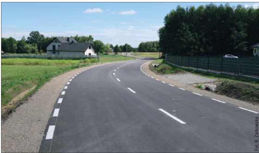
Nowo przebudowana droga powiatowa Kłapówka – Pogwizdów – Hucisko.
