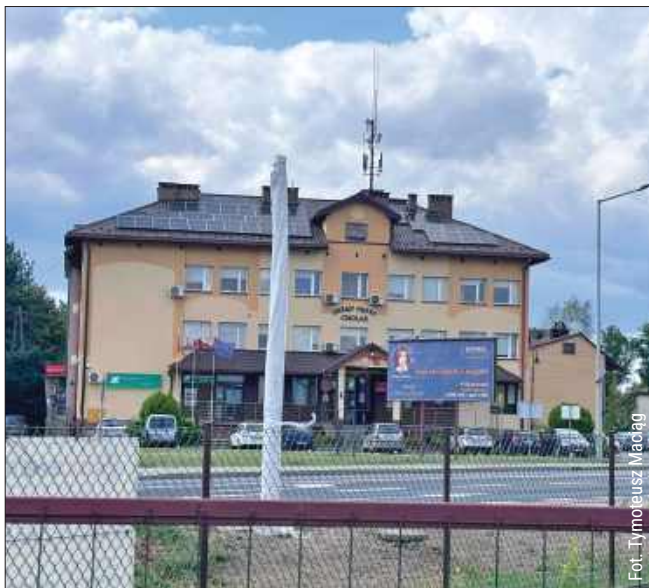
Aktualnie trwa montaż nowego urządzenia rejestrującego prędkość.
