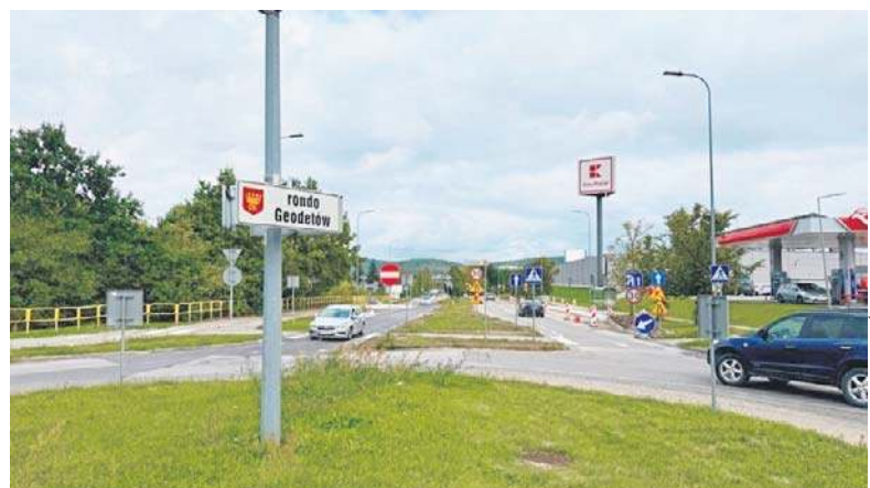
Nowa nawierzchnia pojawi się także na Rondzie Geodetów, które na czas prac będzie całkowicie zamknięte
