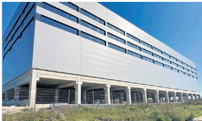
Przy ulicy Sądowniczej w Radomiu powstaje kolejny wielki obiekt produkcyjno – biurowy firmy New Trendy.
