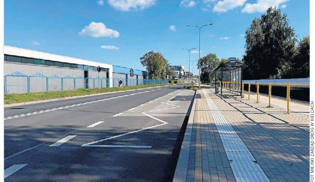
Ulica Wrzosowa zyskała nową nawierzchnię na blisko kilometrowym odcinku od ulicy Świerkowej do rejonu Alei Popiełuszki
