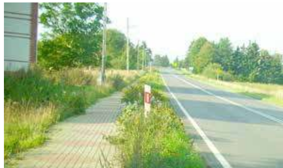
Po stronie lewej, w części zarośnięty chodnik, który dalej będzie służył tylko i wyłącznie pieszym. Chyba, że ktoś chce się narazić na mandat
