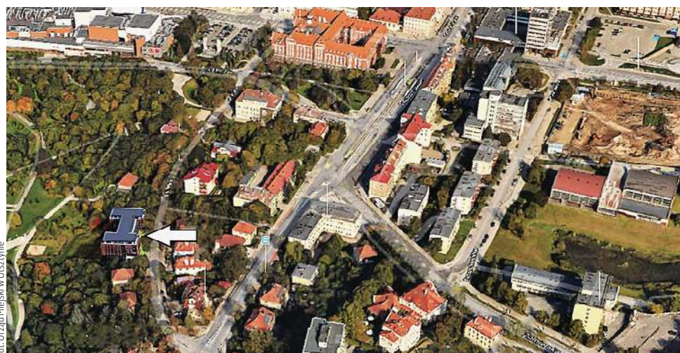
W tym miejscu miał stanąć apartamentowiec
