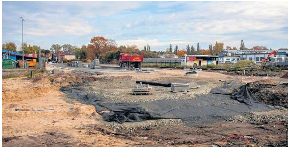
Budowa słupskiego ringu miejskiego jest opóźniona o kilka miesięcy
