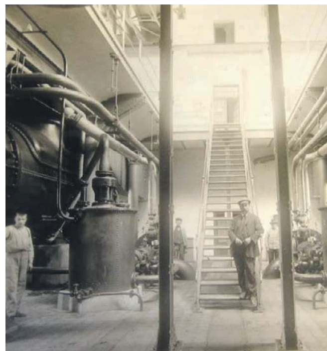
Wnętrze pierwszej sierszańskiej elektrowni. Zdjęcie, najprawdopodobniej z początku lat 20. minionego wieku, pochodzi ze zbiorów Elektrowni Siersza
