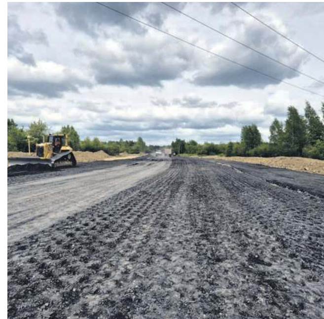
Trwa budowa obwodnicy Jankowic i Olszyn
