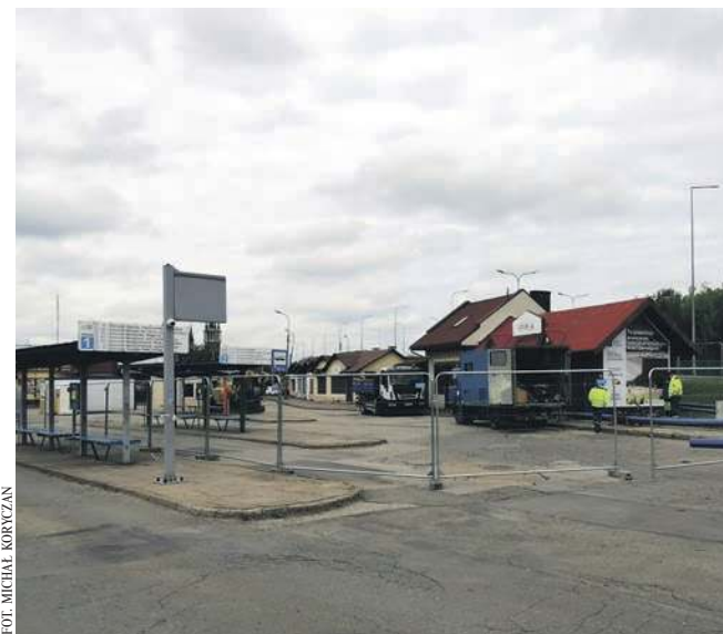
W tym miejscu powstanie centrum przesiadkowe
