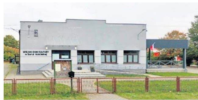
Jednym z założeń projektu będzie wymiana ogrodzenia
