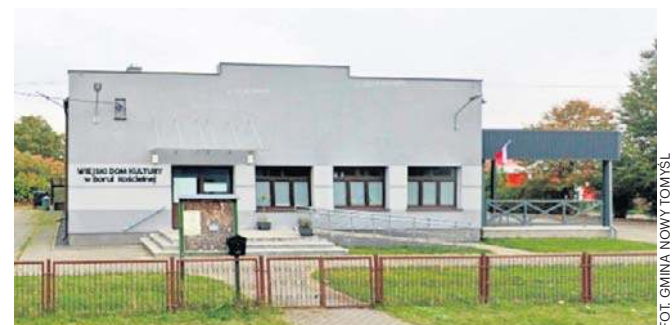
Jednym z założeń projektu będzie wymiana ogrodzenia
