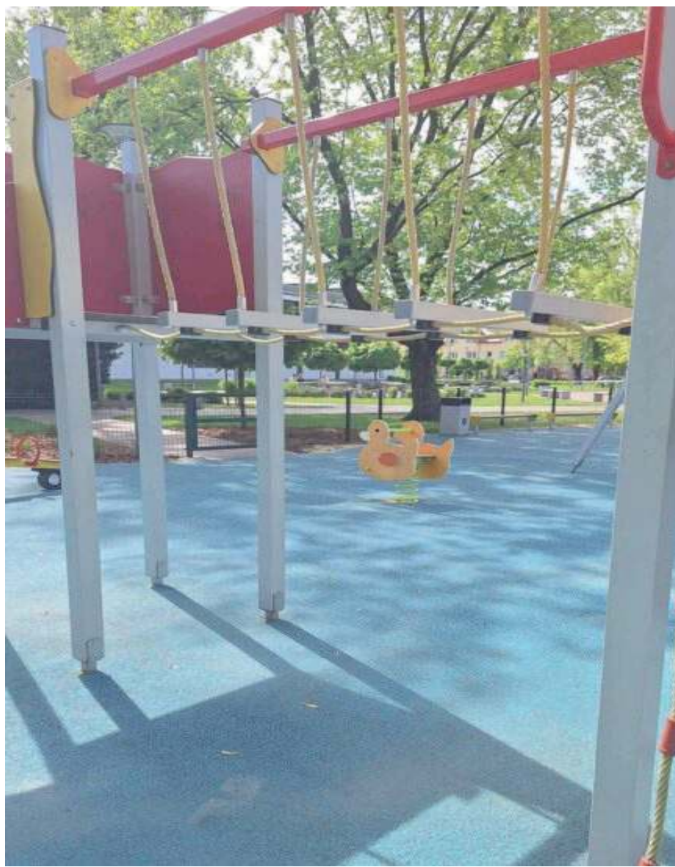
Upadek z 1,5 wysokości może zakończyć się fatalnie. Siatki zabezpieczające jak widać nie ma
