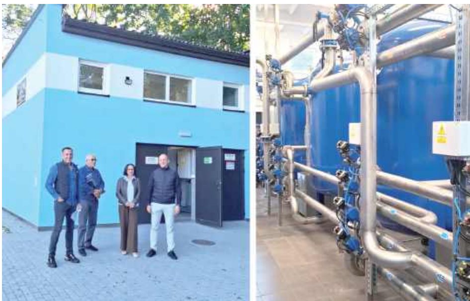
Stacja uzdatniania wody w Żelechowie została przebudowana
