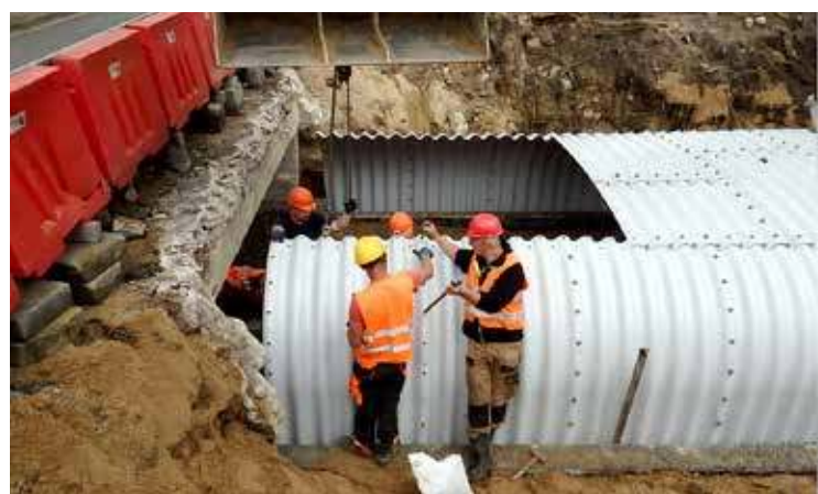
W trakcie prac
