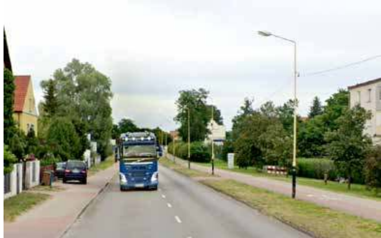
Problem z lampami na ul. Bohaterów Warszawy zgłaszają mieszkańcy okolicznych bloków
