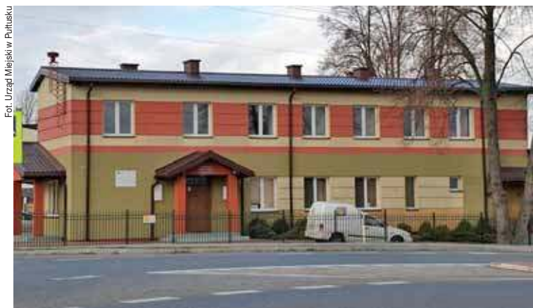
Dach świetlicy został naprawiony
