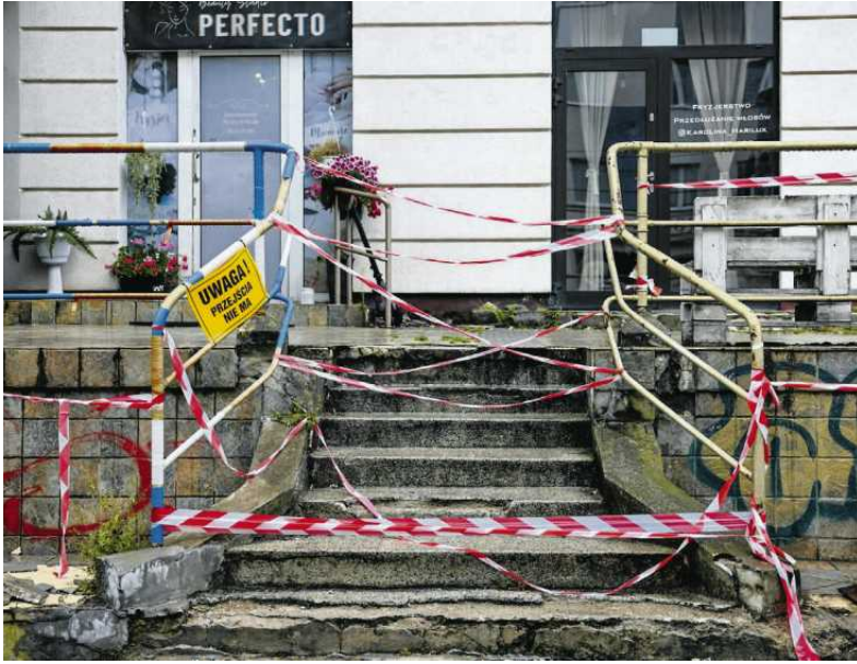
• Taras kamienicy przy ul. Świętojańskiej 81-85 w centrum Gdyni
