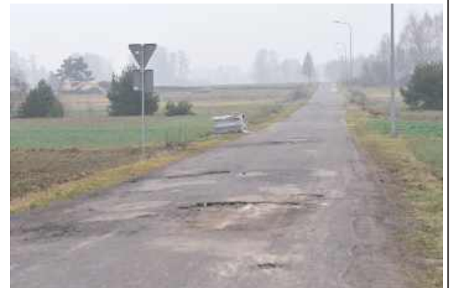
Odcinek w Olszewnicy już niebawem diametralnie zmieni swoje oblicze
