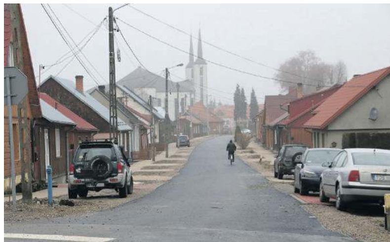
Zmodernizowana ulica Sandomierska w Radomyślu nad Sanem
